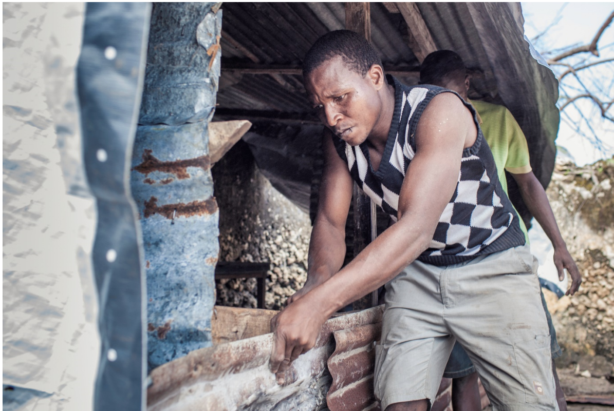
Hamisi Hussein Yusufu (36 ans) construit un abri temporaire pour ses voisins après le passage du cyclone Kenneth
